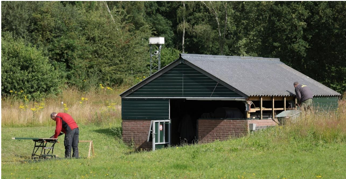
Foto boven: Renovatie observatorium, links Piet Buisman en rechts Mark-Jaap ten Hove in actie (4 juli 2024)
